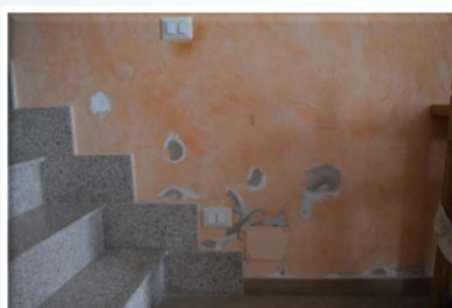
Intervento di iniezioni chimiche ... Appena dopo tre anni di esecuzione...
