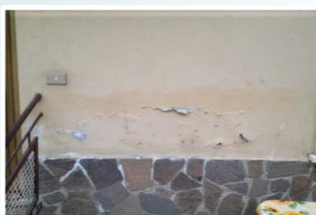
Umidità di risalita che si proietta sopra lo zoccolo
