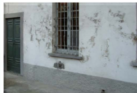
Esecuzione di intonaci macroporosi
