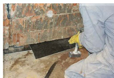
Tagli meccanici ... non a norma con la legge sismica attuale!
