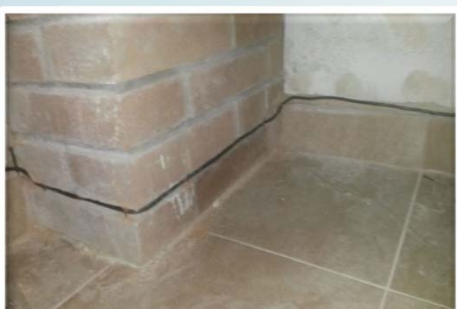
Applicazione del sistema Temperierung basato sulla circolazione di acqua... Oppure, il sistema Thermistore che con un cavo elettrico (220V) scalda la base del muro...
